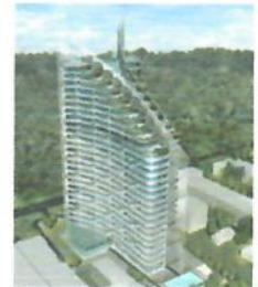
27-этажный жилой дом в г. Сочи
